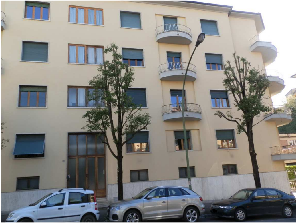
Vista del fabbricato su Via Mazzini
